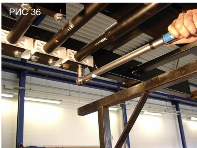
Во избежание отворачивания болтов М16 остальные стопорные шайбы с длинной лапкой также необходимо отогнуть с помощью молотка. Длинную часть стопорной шайбы нужно перегнуть через "фиксированное основание", ударив молотком.
