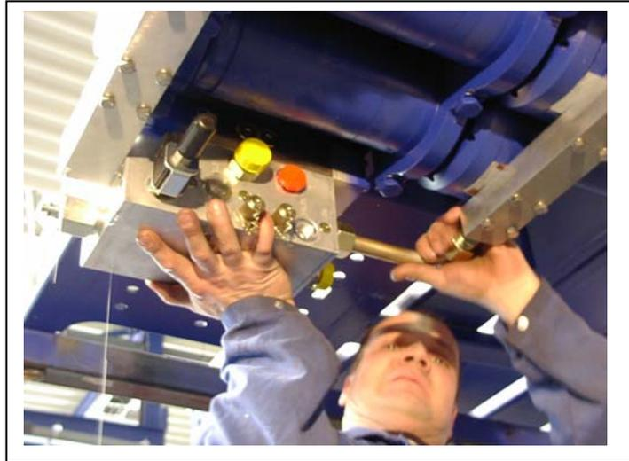
Bringen Sie dann die beiden anderen Leitungen an (P5 und S5); ziehen Sie anschließend alles fest. Ziehen Sie die 4 Schrauben (M8 x 75) der "Common Rail" mit einem Drehmomentschlüssel fest (30 Nm).
