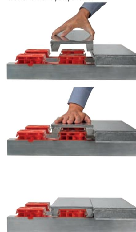
Пластиковый гребень опорного блока
